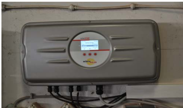
Abb.: Einer von 6 Wechselrichtern
