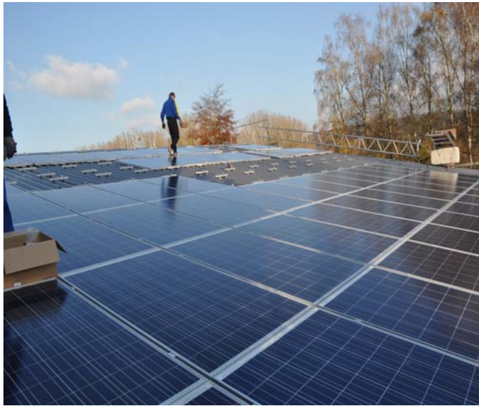
Abb. : Installation der Photovoltaikanlage
